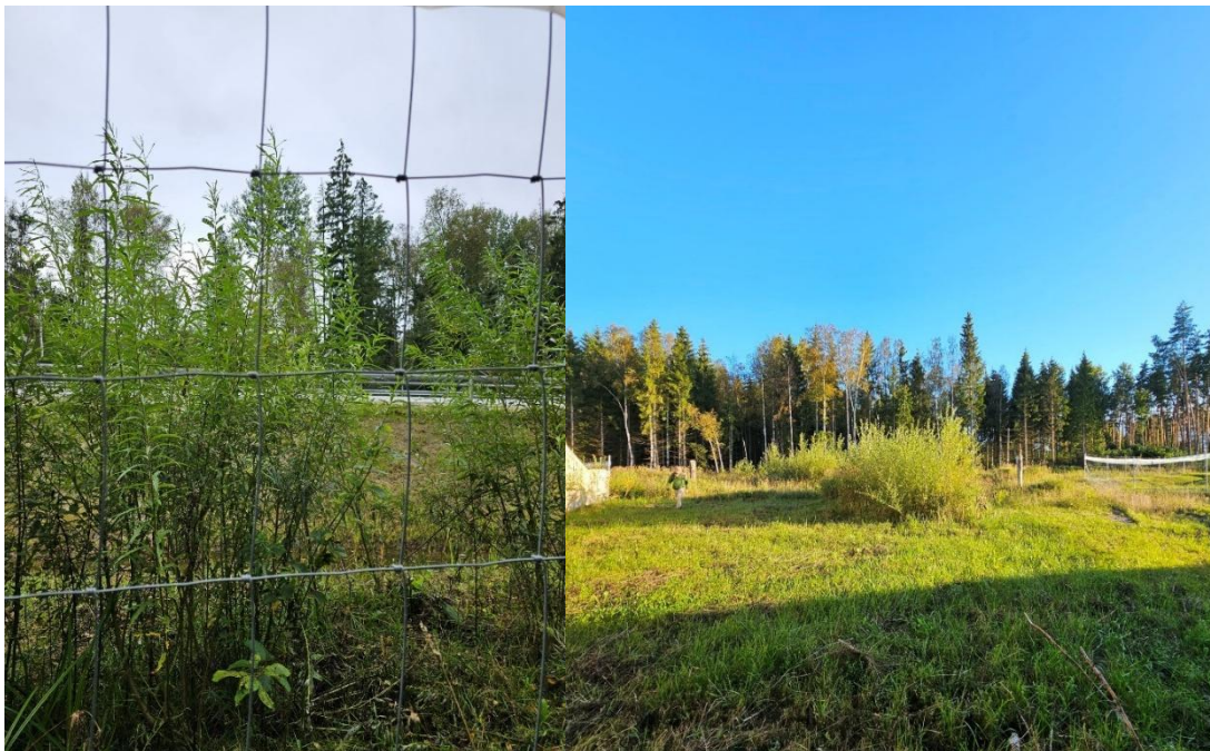
FOTOD 43 JA 44. Vasakpoolsel fotol on näha ulukitarast maantee poole jääv võsa, mis tuleb maha lõigata. Parempoolsel fotol hea näide Leetsi suurulukitunneli suudmest, kus hooldustööde käigus on alles jäetud ulukeid läbipääsu poole suunav võsariba.
