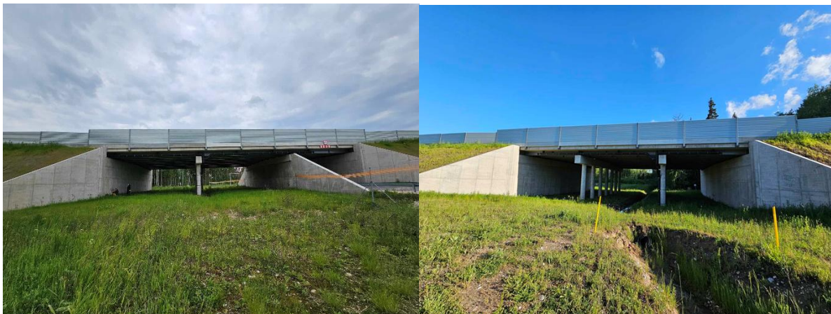
FOTOD 1 JA 2. Leetsi ja Kardla suurulukitunnelid. Leetsi (vasakpoolne) tunnel on kombineeritud minimaalse liiklusega kogujatee läbipääsuga.
