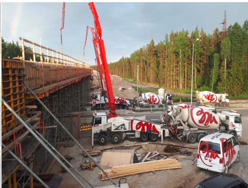
Saku II viadukti betoneerimine 19. juuni õhtul. Õnnetu avariini on jäänud loetud tunnid.
