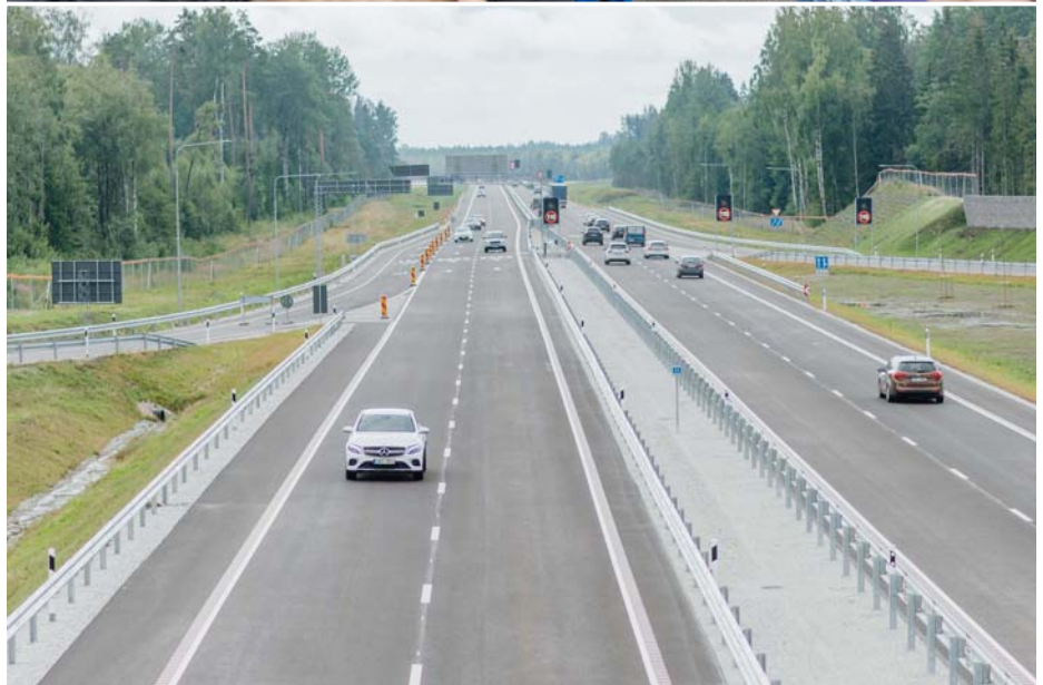
Vaade Ardu viaduktilt Tartu suunas.
