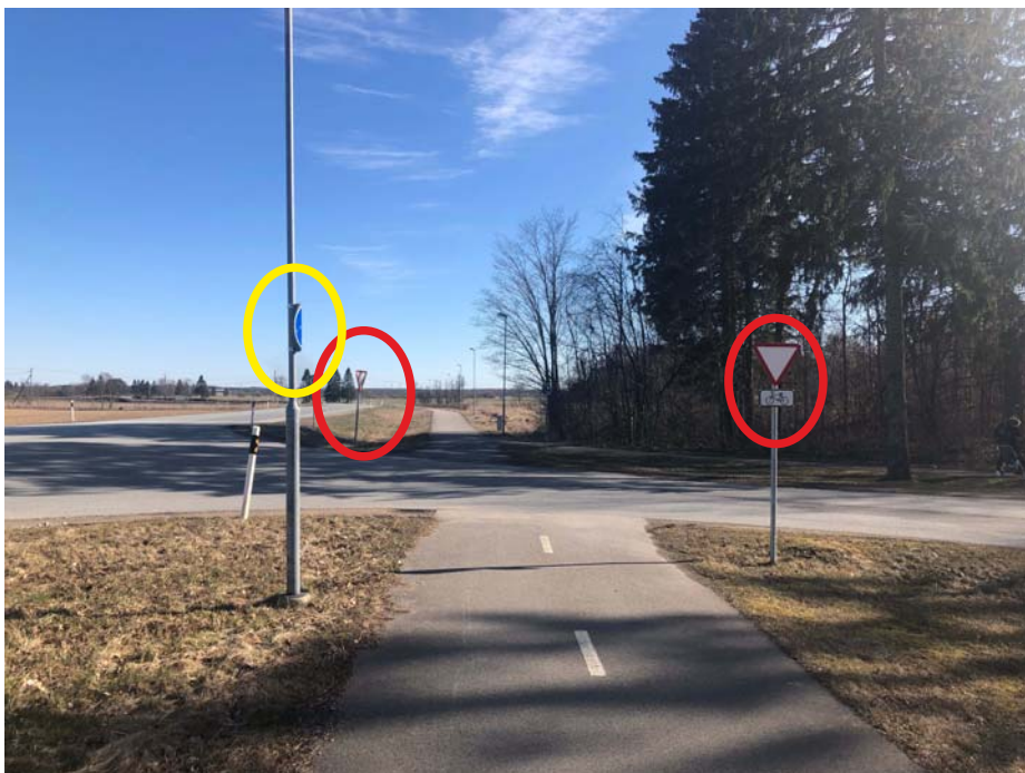
Foto 2. Liiklusmärgid „Anna teed“ ja „märk 847“ on jalgratta- ja jalgteel ühelt poolt tulles paigaldatud, kuid teiselt poolt tulles mitte (pildil nähtav teine märk „Anna teed“ on mõeldud tanklast väljuvatele mootorsõidukitele). Kellele on mõeldud liiklusmärk „Jalgratta- ja jalgteel“ valgustusmasti küljes?
