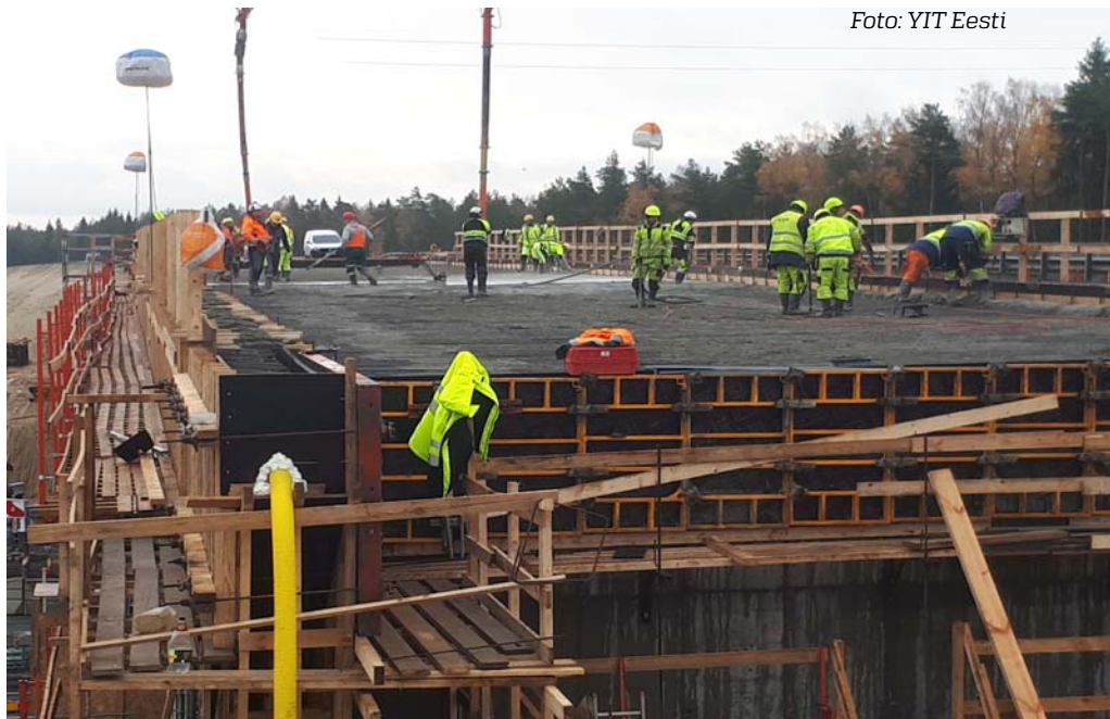
Saku I viadukti betoneerimine (oktoober 2019).
