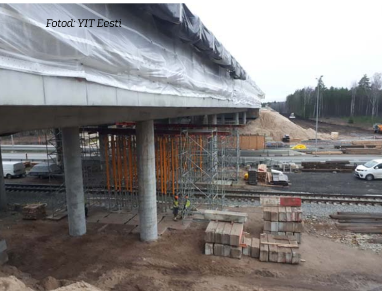
Saku I viadukti hüdroisolatsioonitöid tehti selleks ehitatud ajutises telgis (november 2019).
