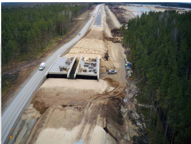
Tammemäe viaduktide ehituse ajal liigeldakse ajutisel teel (jaanuar 2020).
