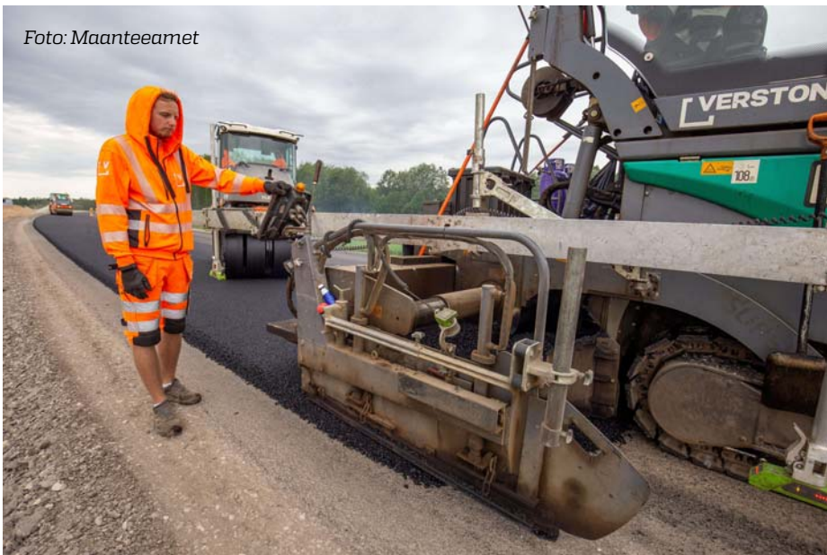
Mäeküla-Suurpalu katselõigul käis tavapärase asfalteerimine. Segusse lisatud plastgraanulid ei mõjutanud töid kuidagi.
