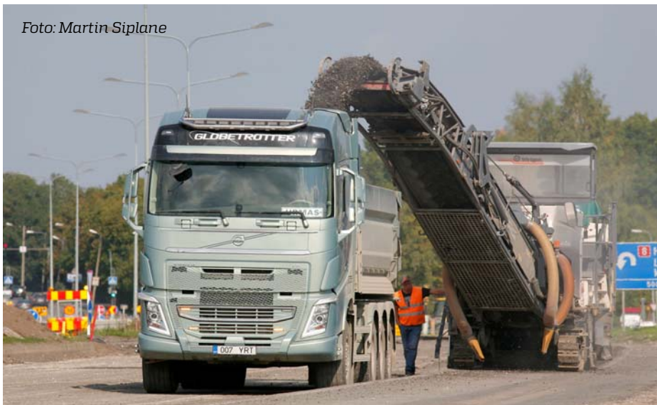
Freesitud asfaldi saab taaskasutada nii stabiliseeritud kihis kui ka asfaltsegus.
